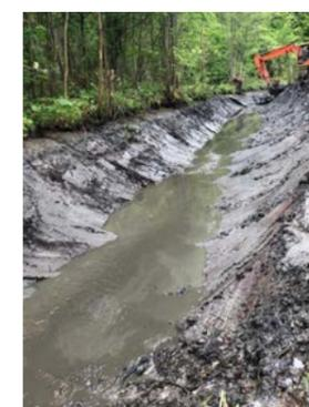
Le réseau hydraulique de Chaalis comprend un réseau de canaux et de douves ainsi que 3 étangs. En 2021, les canaux ont été reprofilés pour favoriser l'écoulement des eaux, la douve du Moulin a été curée, la berge de la roseraie botanique a été renforcée et la poutre des grandes vannes, qui commande l'entrée du réseau, a été changée.
